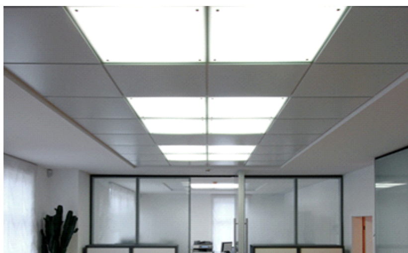
Подвесной потолок со скрытой системой крепления Clip-in
