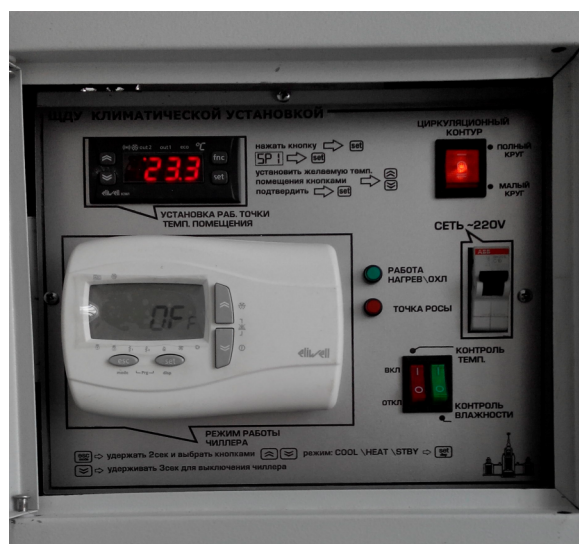
Блок управления системой нагрева и охлаждения.
